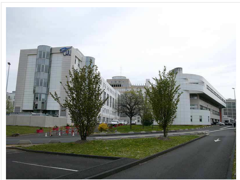
Le centre CALORIS est situé au sein du CHU Montpied, à Clermont-Ferrand
